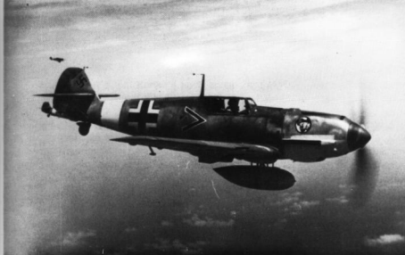
Das »Afrika-Geschwader«, wie das JG 27 später allgemein genannt wurde, trifft im neuen Kampfraum ein. Bf 109E-4/N des Adjutanten I./JG 27, Oblt. Franzisket, beim Verlegeflug von Catania nach Castel Benito, April 1941. Unter dem Rumpf ein 300-l-Zusatztank.
