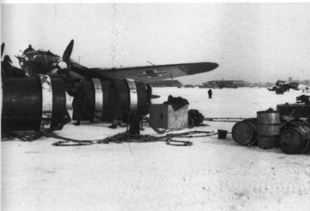
Rollende Benzintanks, Stahlzylinder von 1,60 m Durchmesser und mit breiten Rollbändern verstärkt, konnten zum Betanken unmittelbar an die Flugzeuge herangerollt werden. Auch He 111 wurden für Versorgungsflüge in den Kessel von Demjansk herangezogen. Pleskau, Februar 1942.
