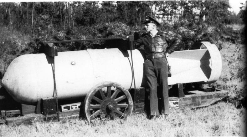
Die schwerste Bombe, die bei der Luftwaffe Verwendung fand, war die Großladungsbombe SB 2500 -Max-. 1700 kg des Gewichtes entfielen auf die Sprengladung. Die Max auf einem Spezialwagen beim KG 1 in Dno, Frühjahr 1942.
