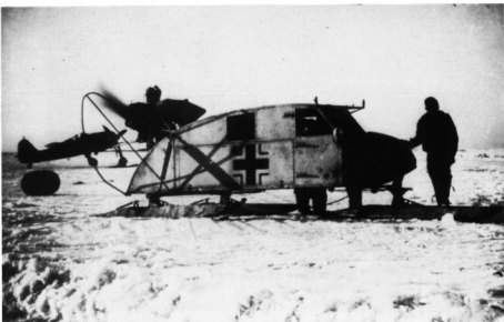
Mehr zur sportlichen Betätigung diente bei der IV./JG 51 dieser erbeutete russische Motorschlitten. Ein leichter Flugzeugmotor trieb über einen Heckpropeller das seltsam anmutende Fahrzeug an.
